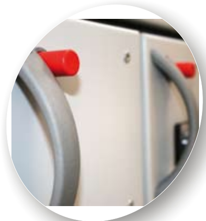
Rys. 8. Uchwyty kaset rozdzielnicy MD
